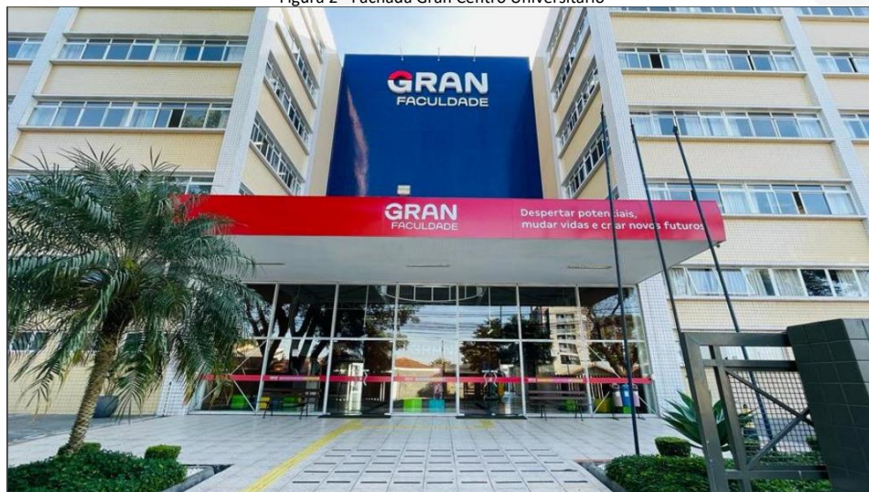
Figura 2 - Fachada Gran Centro Universitário
